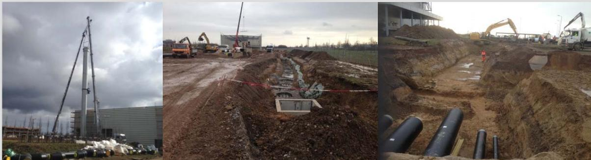
Infrastrukturmaßnahmen Medienversorgung Trinkwasser, Heizung, Druckluft, Feuerlösch, Elektroschächte mit Kabelleerrohren sowie:
